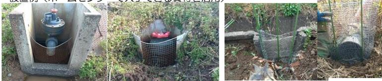
例1) 給水バルブにBBQ網を半円形に曲げて設置 例2) 平織り金網を支柱で固定
