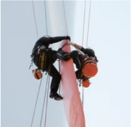
風車の点検整備の様子
