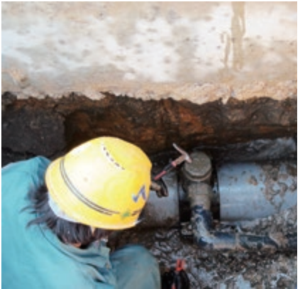
水道管の漏水修理の様子
