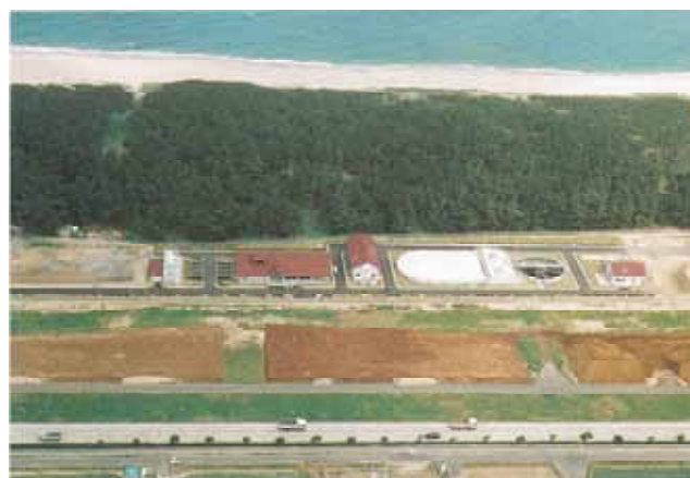
北条下水道管理センター
