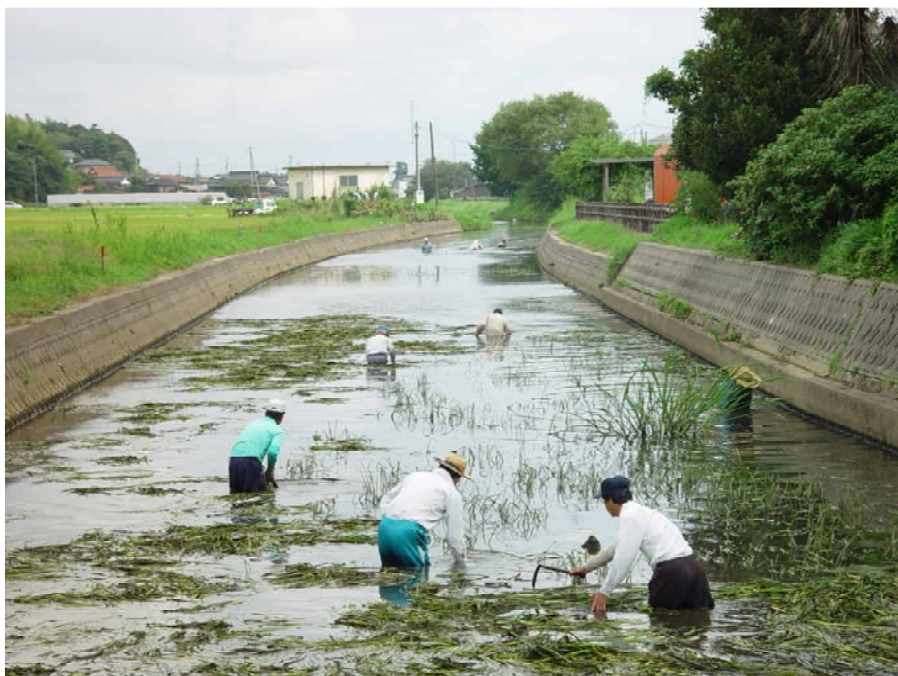
円城寺川（北栄町大島付近）での藻切り作業風景
