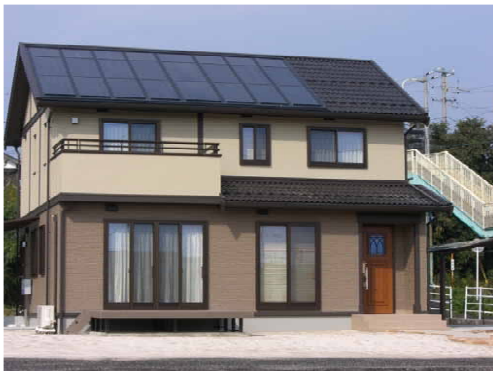
住宅用太陽光発電システムの設置状況
