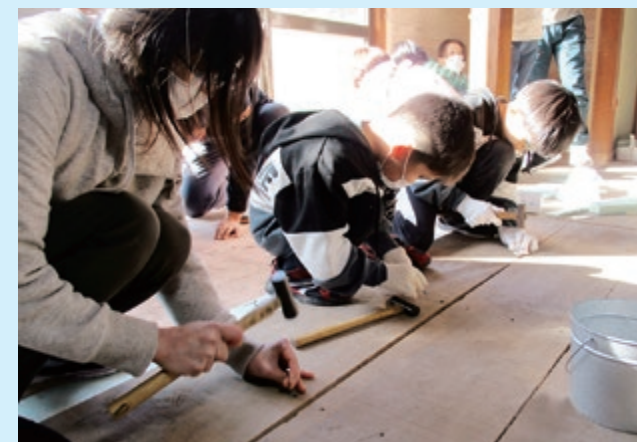
断熱材をしいて床板を釘で打つ子どもたち
