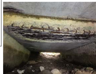
コンクリートの剥離
