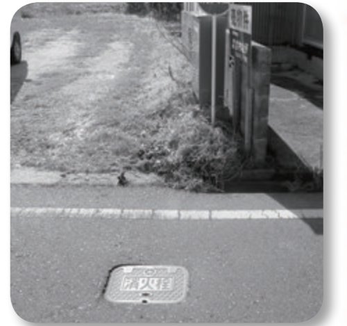
道路にある地下式消火栓
