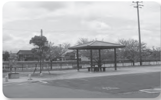
出合いの広場に新設された東屋
