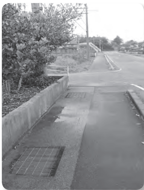
排水路が直接前川に接続していない
