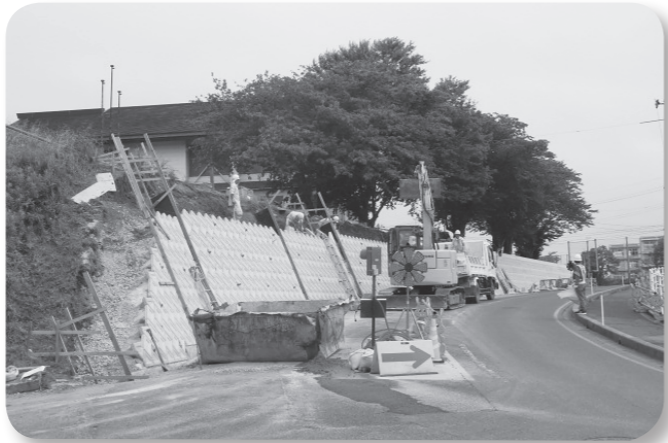
町内業者が受注した大栄中学校の法面工事
