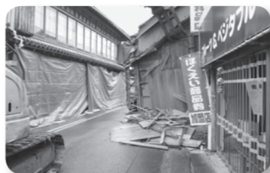
由良宿内で倒壊した建物（右奥）
