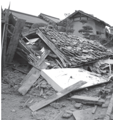
道路上に倒壊した建物
