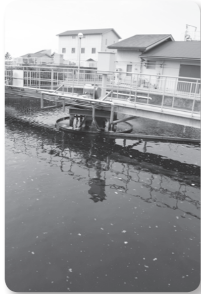
大栄浄化センターの沈殿池
