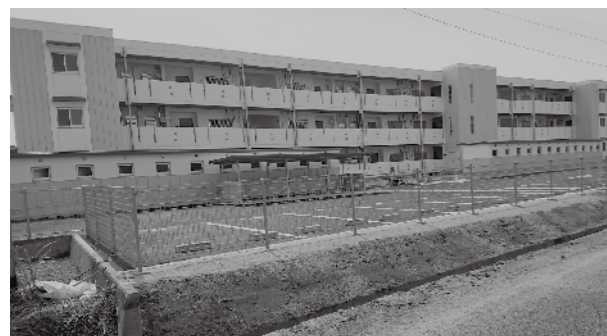
完成した第2期の新団地（24戸）
