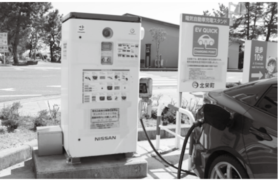
ふるさと館駐車場の急速充電器
