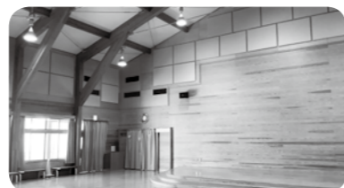
上部に張られた吸音パネル
