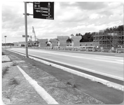
着々と進む山陰道の工事
