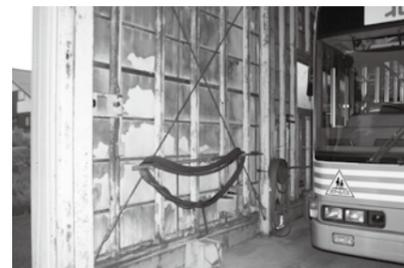
鉄骨柱の腐食が著しい
