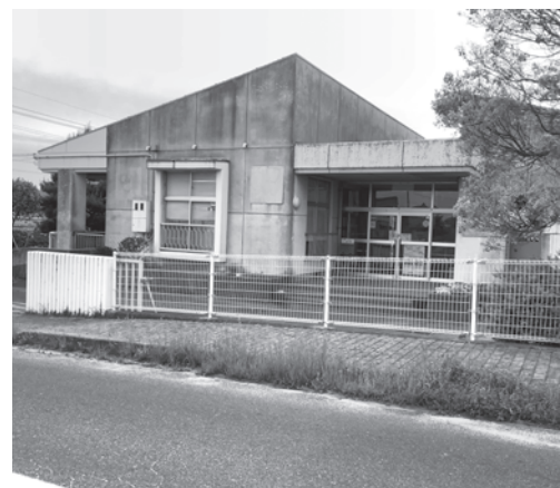
民間事業所へ貸し出し中の元東保育所
