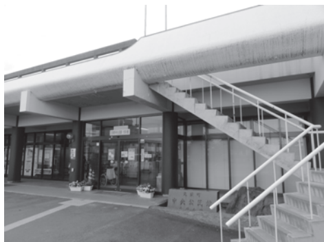
昭和46年竣工 築50年の老朽化が著しい大栄分館
