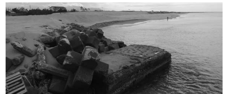
由良川河口部西側の消波ブロック
