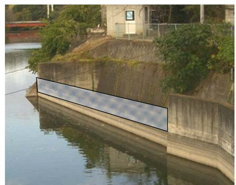
写真7：越流断面（青網掛け部分）
