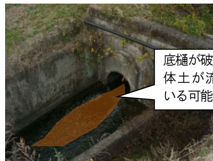
写真11：底樋出口（堤体下流）
