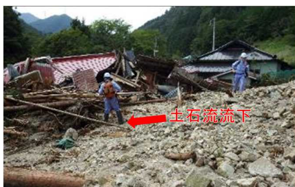
土石流出状況(滝向沢)
