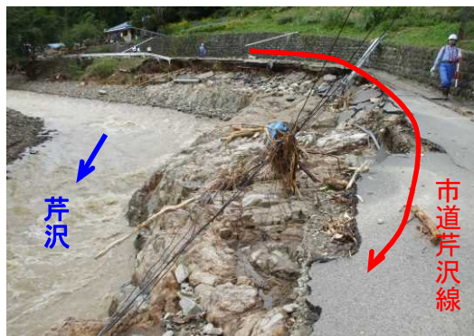
市道芹沢線の崩落状況
