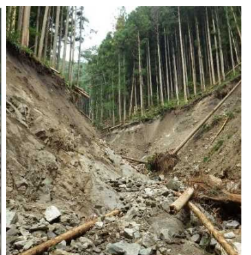
土石流出状況(中坪上沢)
