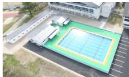
完成したプール
