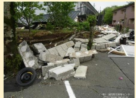
倒壊したブロック塀（平成28年熊本地震）
