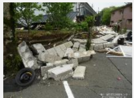
倒壊したブロック塀(平成 28 年熊本大震災)
