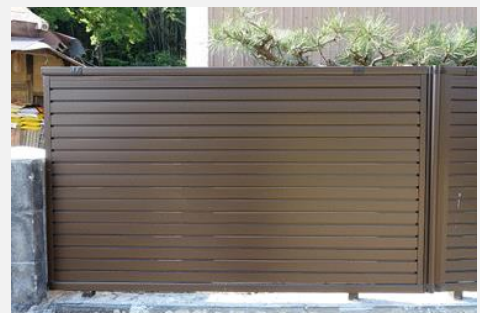
安全な軽量フェンスへの改修例
