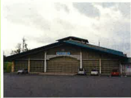
〔屋内体育福祉施設「希望の館」〕
