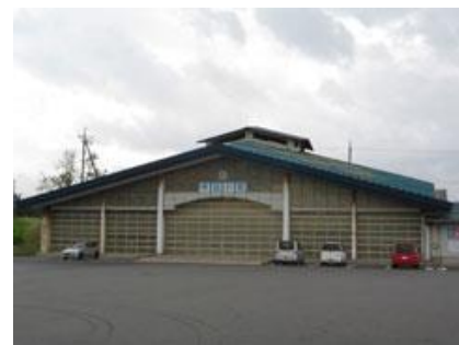
〔屋内体育福祉施設「希望の館」〕
