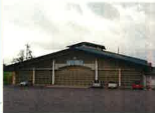
〔屋内体育福祉施設「希望の館」〕
