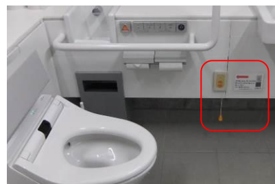
▲緊急時の呼出しボタンを設置した事例
