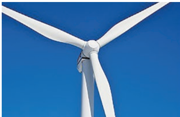
北条砂丘風力発電所
