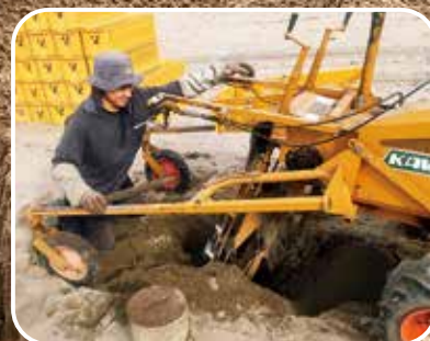
トレンチャーによる掘り取り
