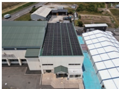
太陽光パネル
