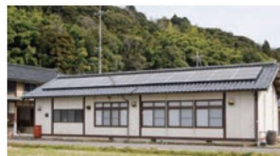
自治会公民館の太陽光発電設備に補助金
