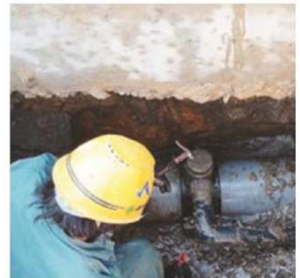
水道管の漏水修理の様子
