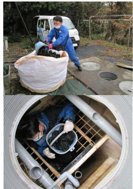
浄化槽修繕作業(内部修繕のため内部構造材を一時撤去している様子)
