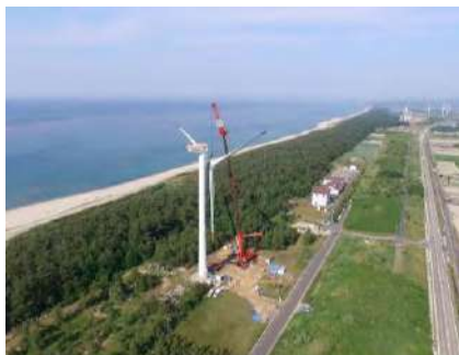
風車4号機の修理の様子
