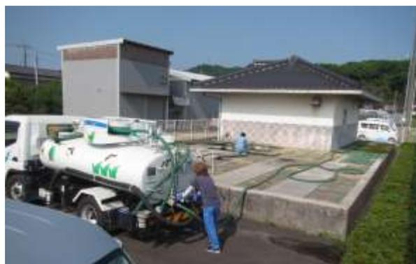
農業集落排水事業の処理施設クリーンセンター島から処理した汚泥を年間3回程度、一般廃棄物として中部クリーンセンター（し尿処理場 倉吉市小田）へ運搬
