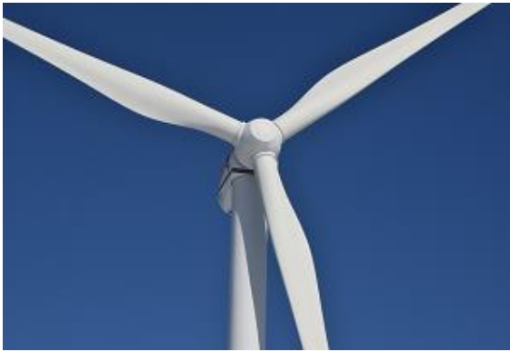
北条砂丘風力発電所
