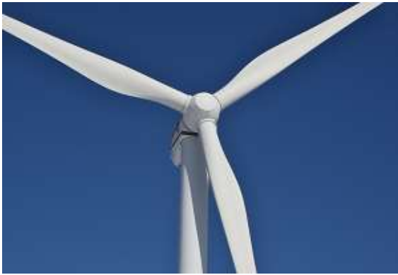
北条砂丘風力発電所
