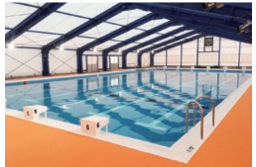
木質バイオマスボイラーを使った適温のプールを利用できます
