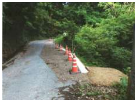
東高尾上坂線（施工状況）
