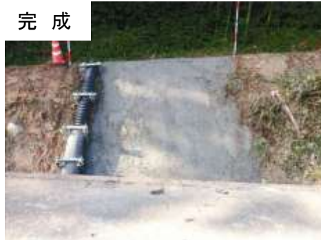
法面修繕（岩坪地区）
