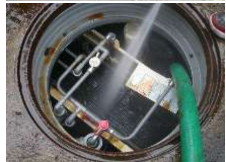
浄化槽清掃作業の様子
