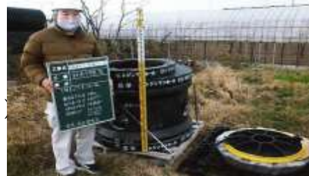
接続工事に使うレジンマンホールの検査
