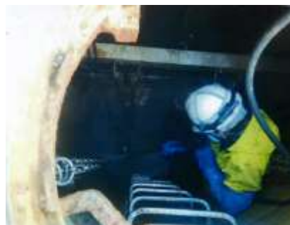
マンホール清掃
