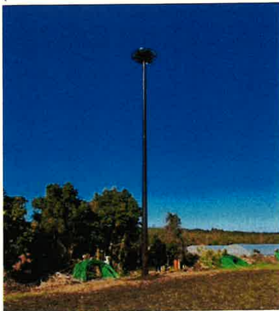
建設直後の巣塔
