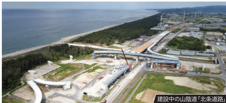
建設中の山陰道「北条道路」
