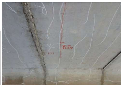
前田橋1に生じたひび割れ
