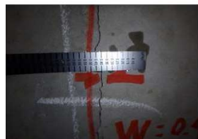
前田橋1に生じたひび割れ
