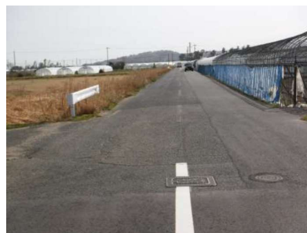
舗装補修箇所(町道大野西新田場線)
