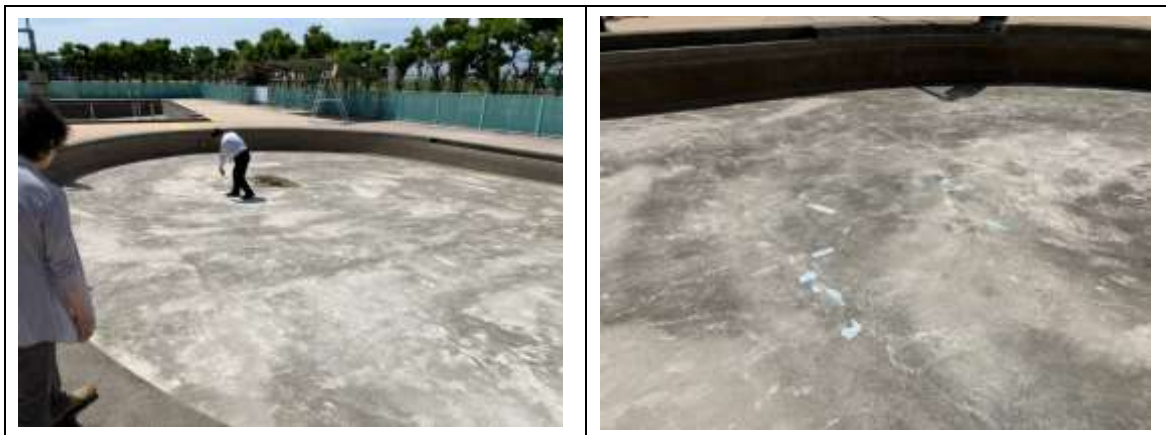
築50年を迎えあちこちでセメントが劣化し、プール底でひび割れや剥落が著しい。
