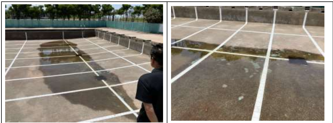
築50年を迎えあちこちでセメントが劣化し、プール底でひび割れや剥落が著しい。
