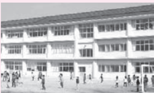
北条小屋根の太陽光発電パネル
