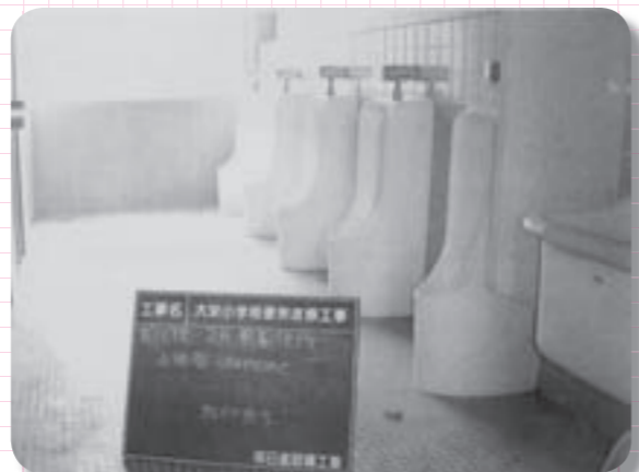
大栄小のトイレ改修
