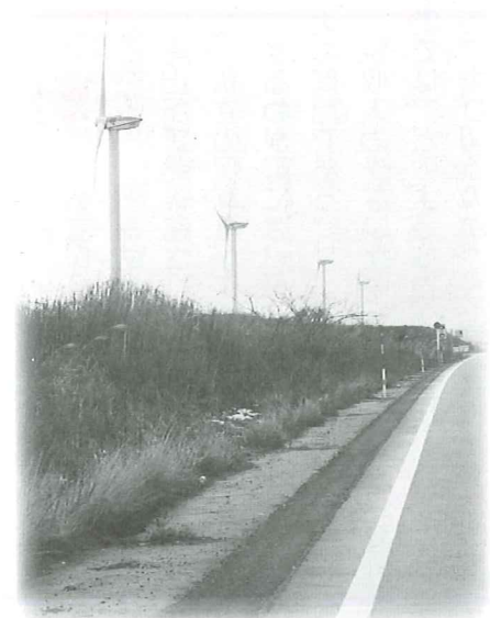
北条バイパスの盛土
