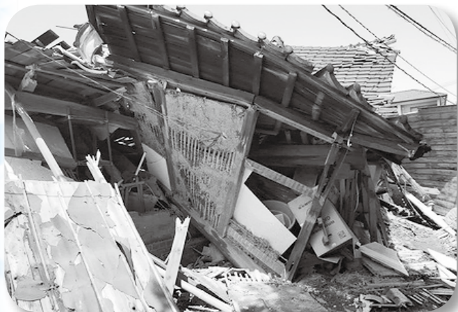
熊本地震で被災した民家
