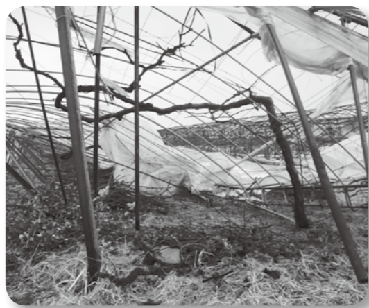
平成23年の大雪で被害にあったハウス
