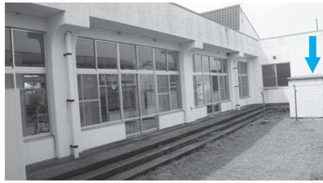
工事予定地に設置されていた倉庫 (矢印)
