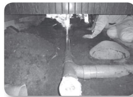
下水道の宅内工事
