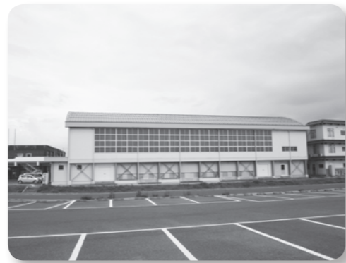
耐震改修が完了した大栄体育館
