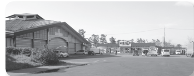
道の駅北条砂丘公園センターの全景
