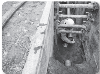
下水道工事の現場
