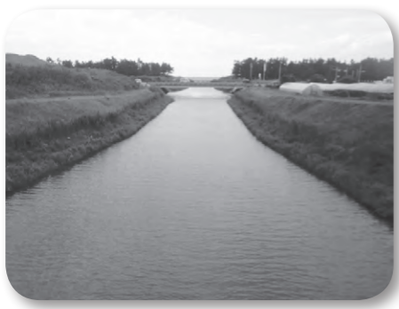
修復予定の下流側
