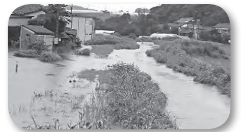
豪雨時の東亀谷作業所裏付近
