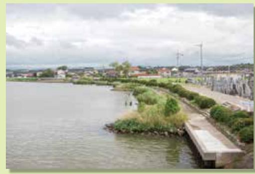
由良川の水制工は、江戸時代、舟着場付近の下流に木枠の番杭が造られ、逆波と舟運の安全が保たれたが、明治の大洪水によりその姿を失った。現在の水制工は、平成8年に改良と復元が行われ、河川を保全しながら流域の文化を育てている。
