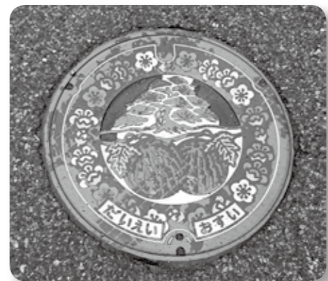
下水道マンホール
