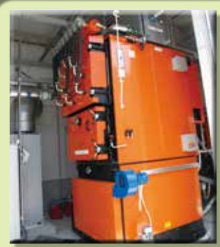
バイオマスボイラー
