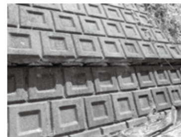
令和3年7月豪雨で崩壊した法面
