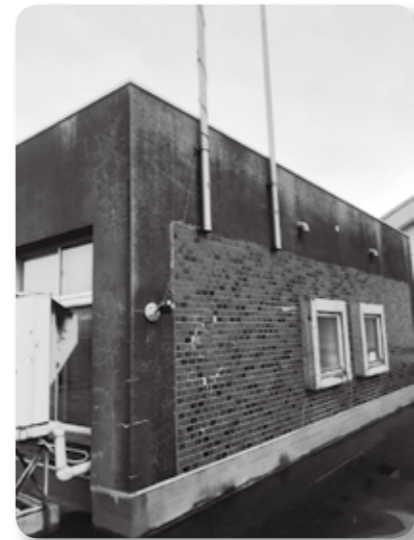
老朽化が進む中央公民館大栄分館（2階外壁）
