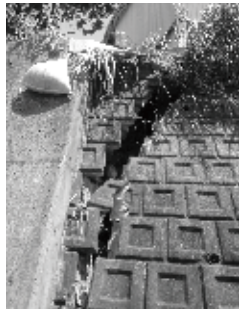
被災した面法
