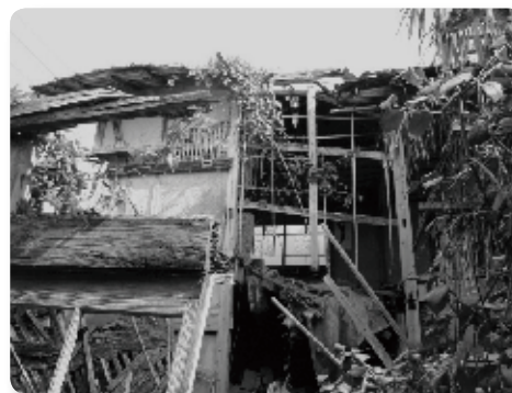
行政代執行された危険空き家
