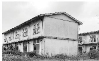
解体前の向山団地
