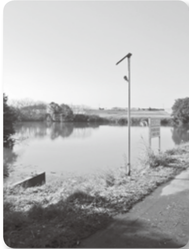
水位を監視するカメラ
